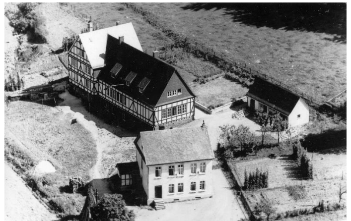
Steegerhütte – Schulen Wann wurde die alte Schule abgebrochen, wer hat die Arbeiten ausgeführt und wohin wurde der Bauschutt transportiert?
